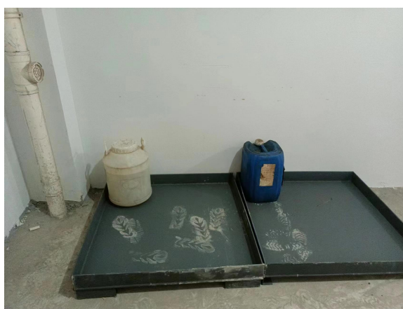
图 4-10 危废暂存桶及防渗托盘
