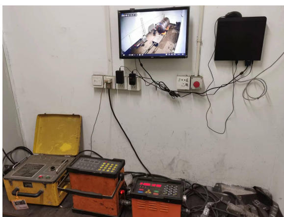
图 4-9 操作台视频监控显示器、紧急停止按钮
