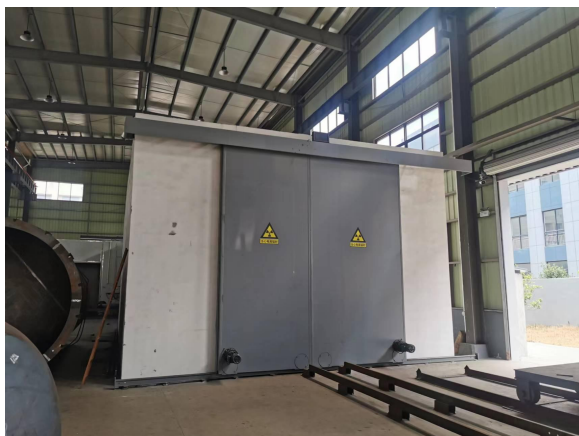
图 4-1 探伤室整体现状
